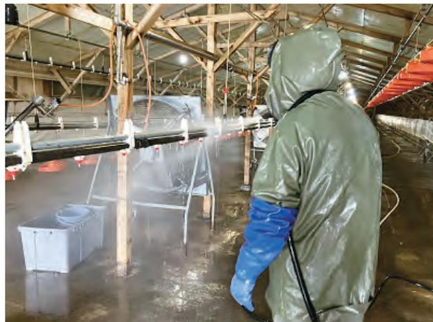
写真：ドリンカーの水洗
