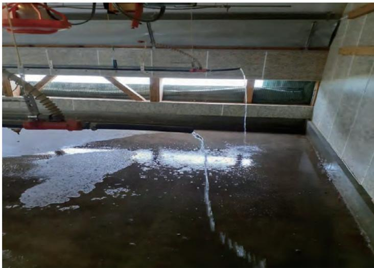
写真：給水管内の洗浄
